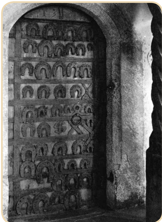
Porta d'ingresso alla casa di fabbro-ferraio Existing entrance door to ancient Blacksmith's House
